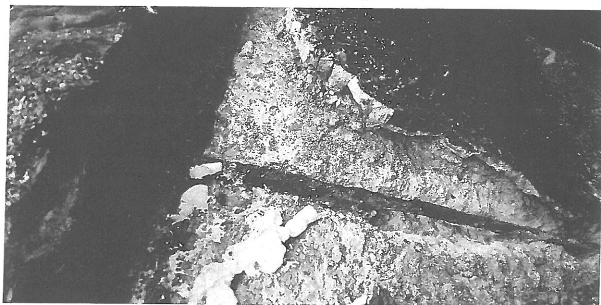
Szkic Nr 18. Degradacja belki głównej – odsłonięte zbrojenie główne oraz strzemiona.
