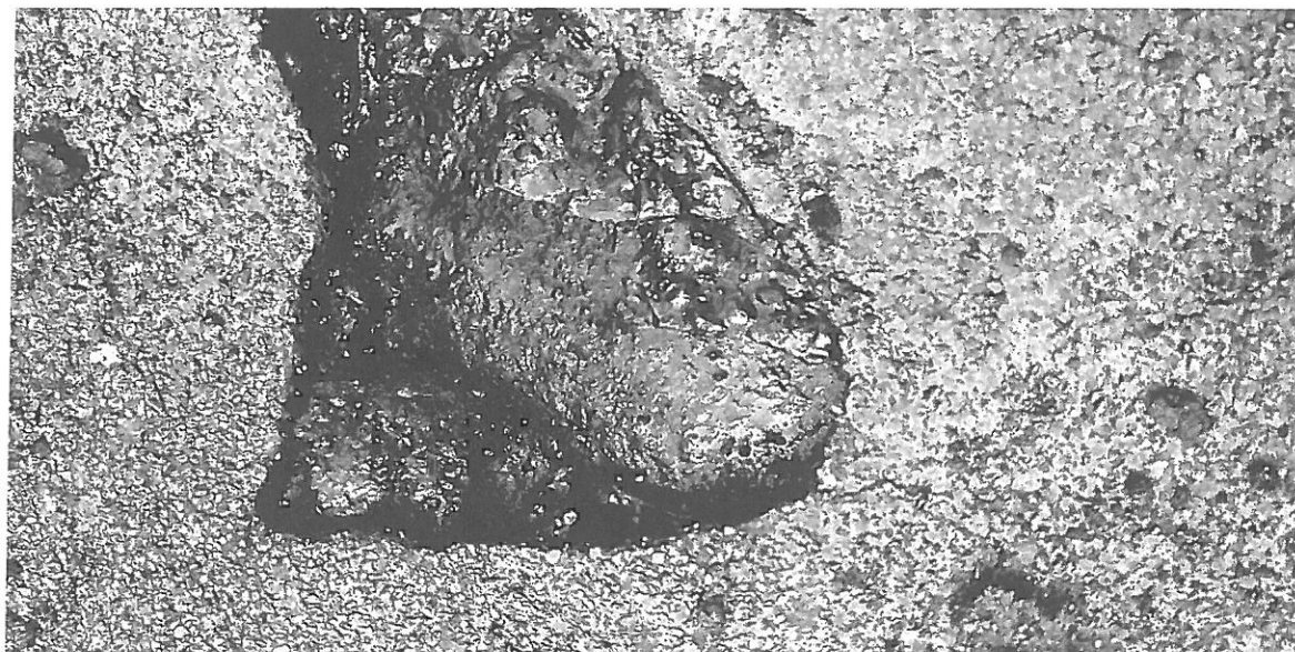
Szkic Nr 16. Woda w warstwach pokrycia papowego.
